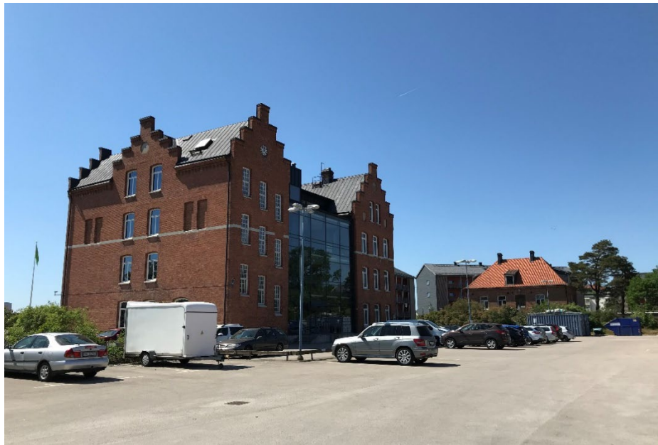
Bild 17. Vy från planområdet mot kanslibyggnaden och kaserngården.
